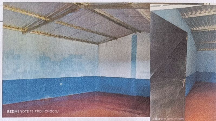
Foto 2: MODULO DE AULAS - MEJORAMIENTO DE PARED
