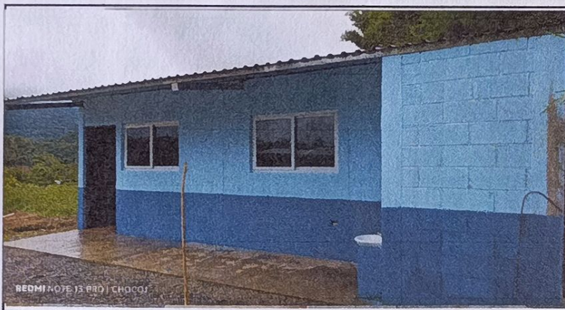
Foto 6: MODULO DE AULAS - mejoramiento de las instalaciones de preprimaria.
