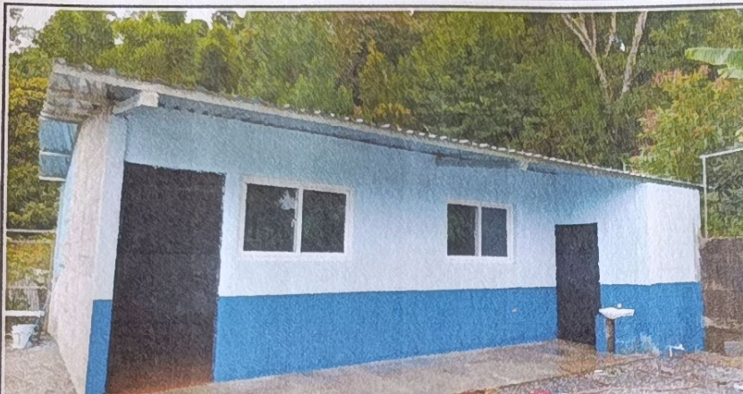
Foto1: MODULO DE AULAS - mejoramiento de puerta y piso y pared
