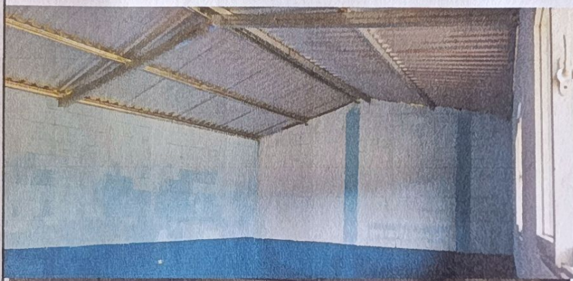
Foto 3: MODULO DE AULAS - Mejoramiento de estructura de techo.
