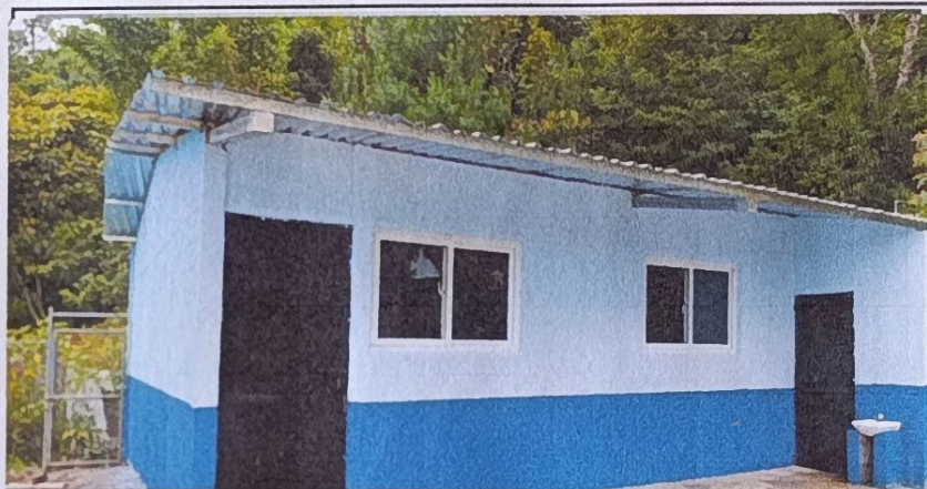
Foto 4: MODULO DE AULAS - mejoramiento de puerta y ventana
